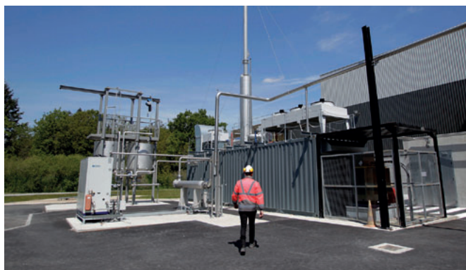
Bâtiment de cogénération de l'UVO
