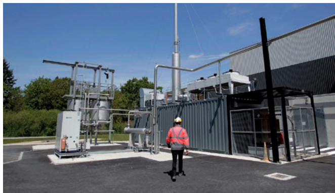
Bâtiment de cogénération de l'UVO
