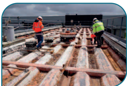
Mai 2021 : Dépose partielle de la toiture du digesteur
