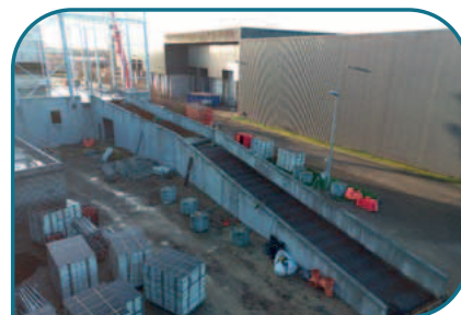
Décembre 2021 : Préparation des rampes d'accès et de sortie du nouveau quai de vidage des véhicules apporteurs
