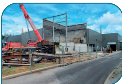
Juin 2021 : Déconstruction du hall des presses
