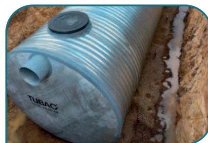
Juillet 2021 : Terrassement et mise en place des cuves de rétention des eaux d'extinction incendie (eaux sales)
