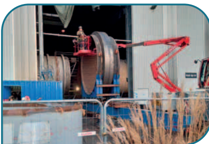
Décembre 2021 : Remplacement de 2 viroles du bioréacteur stabilisateur
