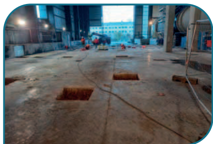
Novembre 2021 : Démantèlement du process de tri des OMR
