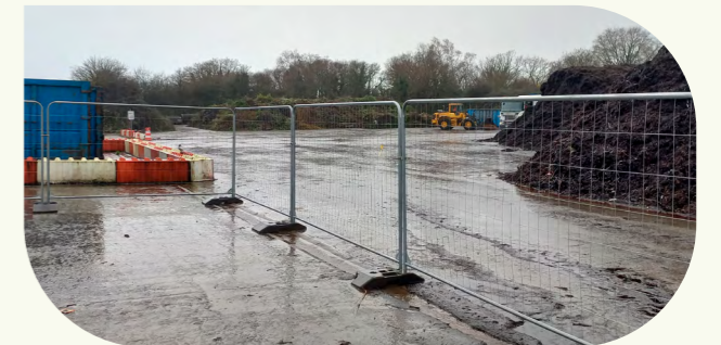
Séparation zone de travaux zone exploitation
